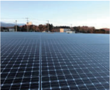
⑥那須塩原太陽光発電設備設置
