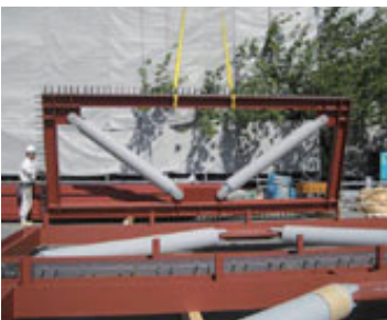
⑤聖籠町役場庁舎耐震補強・外壁改修
