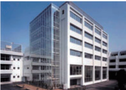
②亜細亜大学新2号館建設
